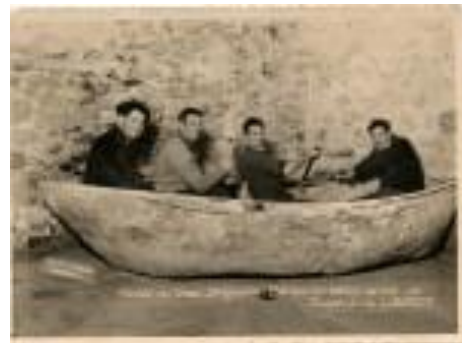
La première barque en ciment armé
